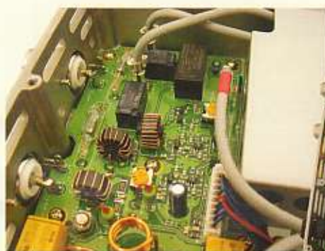
De antenne ingangen
